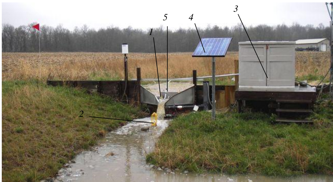
1 – водосборный колодец; 2 – отбор проб поверхностного стока с полей; 3 – будка для хранения проб; 4 – солнечная батарея; 5 – расходомер
