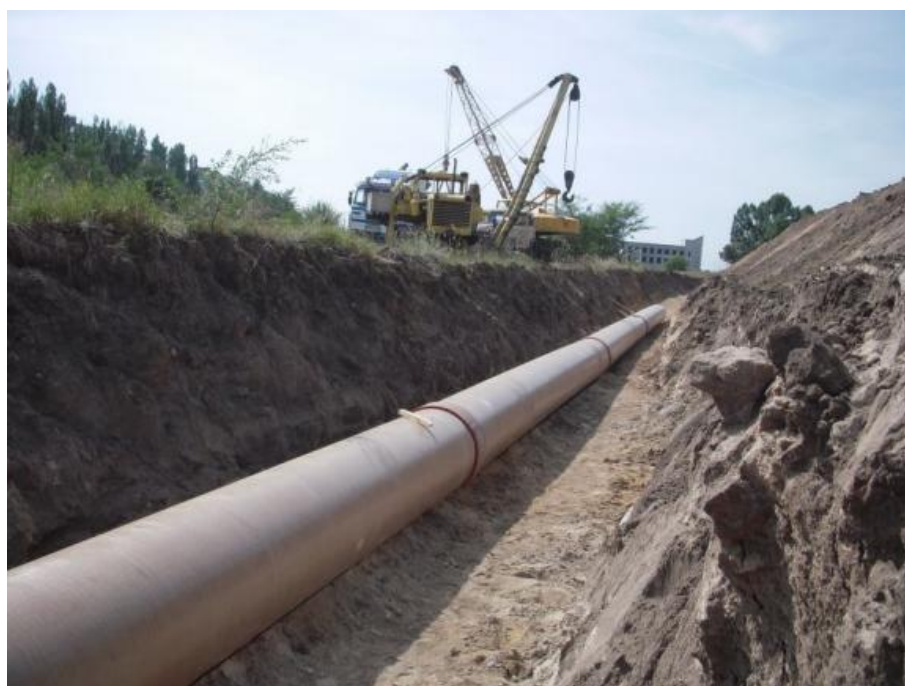
Рисунок 1 – Строительство магистрального трубопровода (фото ООО «Новые трубные технологии»)
