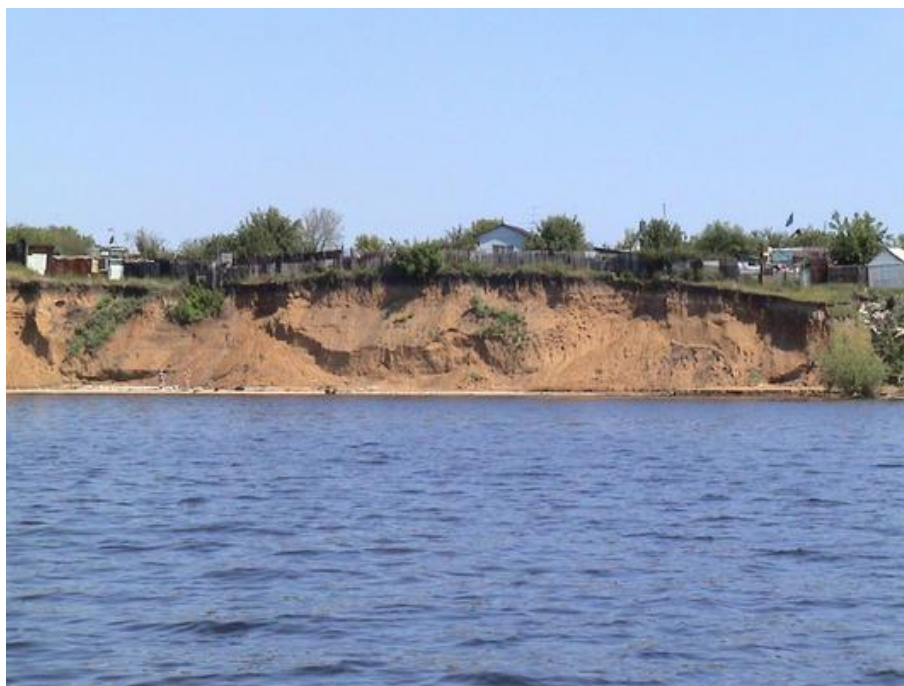
Рисунок 2 – Разрушение берегов Цимлянского водохранилища
