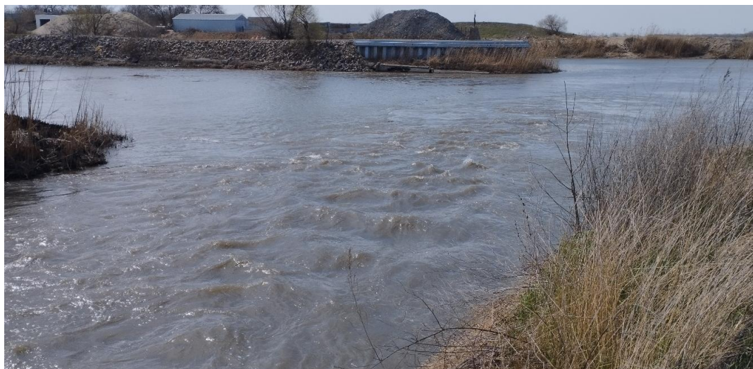
Рисунок 7 – Характер течений на подходном участке к Усть-Манычскому рыбоходному каналу при низких уровнях воды в р. Западный Маныч (фото В. Н. Шкуры)
