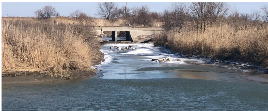
Рисунок 6 – Вид на вход (для рыб) в рыбоходный канал (фото В. Н. Шкуры)
