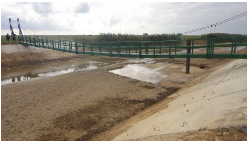
Рисунок 4 – Гидрометрический створ в фиксированном русле канала Р-3 Райгородской оросительной системы (фото А. А. Чураева)
